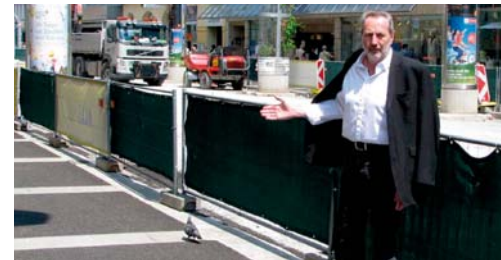
Fertiggestellt sind die ersten Randbereiche der Fußgängerzone – und die Straßenmitte wird nun saniert. So seien Geschäfts- und Hauszüge sowie Lieferung jederzeit möglich, so BV-Stv. Josef Kaindl. Foto: Mf
